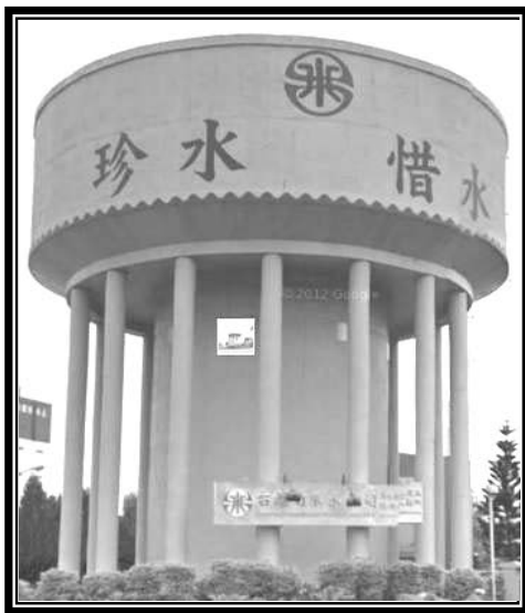
圖 1 高架水塔外觀照片
