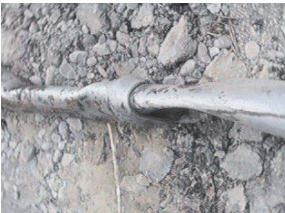
卓蘭鎮食水坑坪林幹39前130公尺150mmPVCP擠壓成蛇行狀
