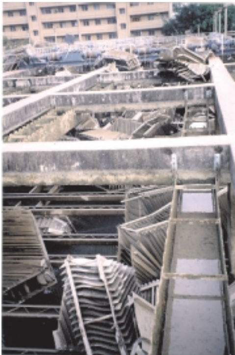
▲豐原第一淨水場沉澱池傾斜板扭曲變形損毀
