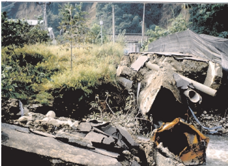
▼豐原第一淨水場2000mmSP輸水幹管損壞情形（擠壓成團狀）
