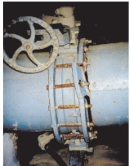
▼豐原第一淨水場2000mmSP輸水幹管損壞情形（擠壓成團狀）
