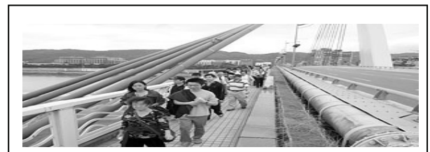
圖 2 大直橋與水管及人行步道共構
