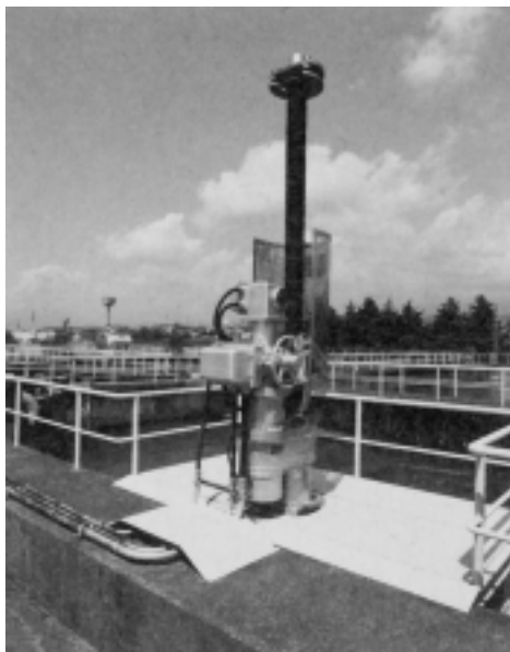
圖-3.4.22 信號式緊急遮斷閥使用例 口徑 2000 mm×2000 mm 以偵測震度方式控制 動力來源為自重 (靜岡縣企業局 富士川事務所 厚原淨水場著水井流入口)
