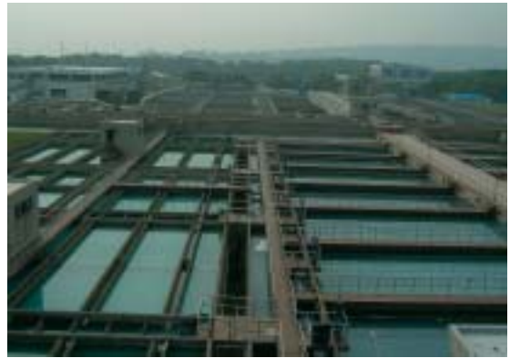
鳳山一期民生用水淨水場軟化工程
