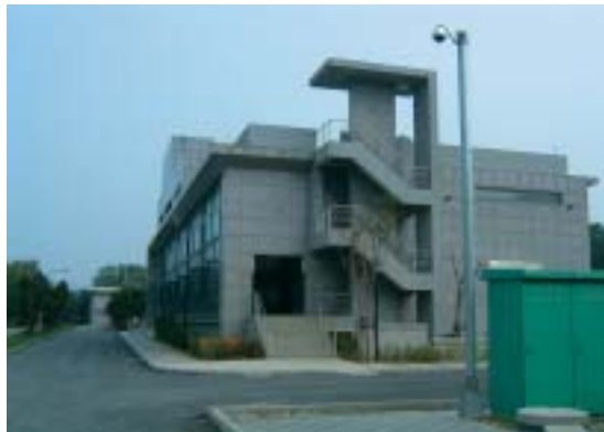
澄清湖淨水場操作中心 Operation Center
