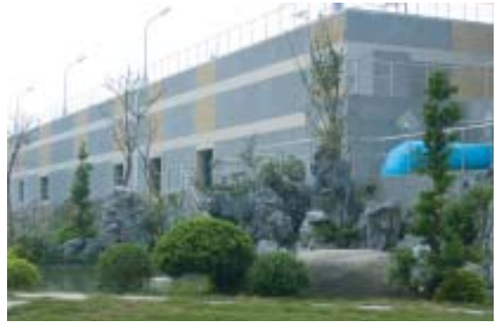
澄清湖淨水場新設生物活性碳濾池BAC Filter
