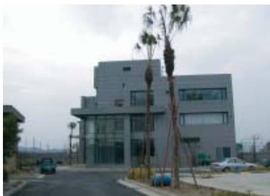
拷潭淨水場操作中心 Operation Center
