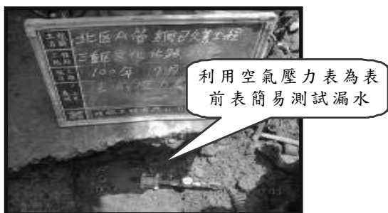
圖 18 空氣壓力表測試情形
