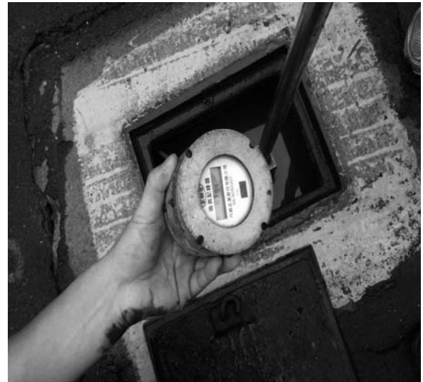
圖 10 消防栓裝設壓力紀錄器
