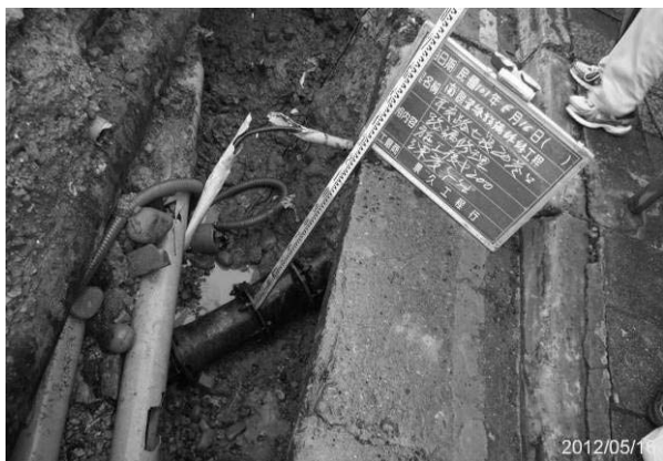
圖 7 修漏開挖作業
