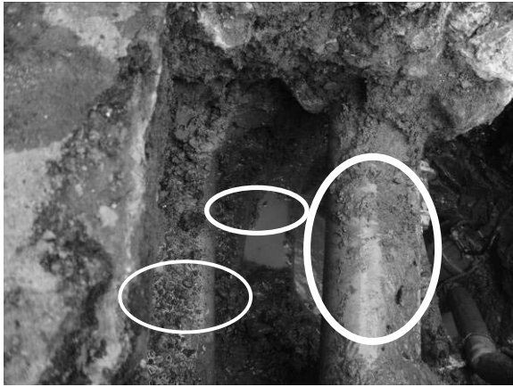
圖 13 本處多支給水管線及配水管平行佈設且與其他管線單位平行-1
