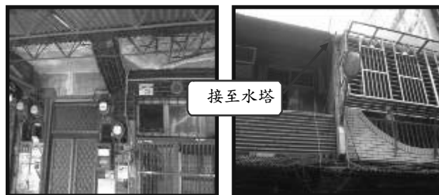
圖 15 內線沿著外牆至水塔情形（二）
