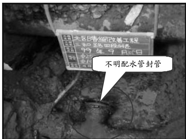
圖 9 不明配水管封管情形
