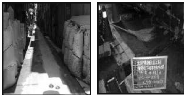
圖 19 防火巷埋設給水管情形
