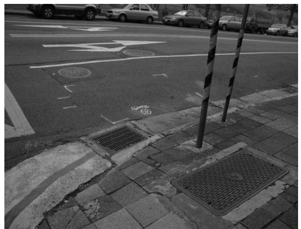
圖 6 檢測確認作業-2
