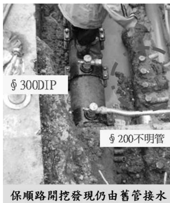
圖 12 保順路開挖施工
