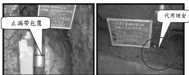
圖 8 不明管以埋金或止漏帶包覆情形
