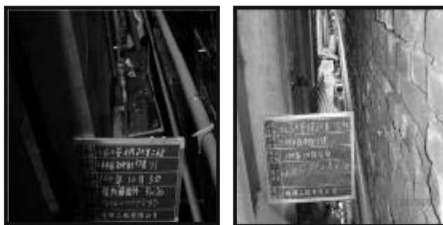
圖 20 防火巷以明管安裝給水管情形
