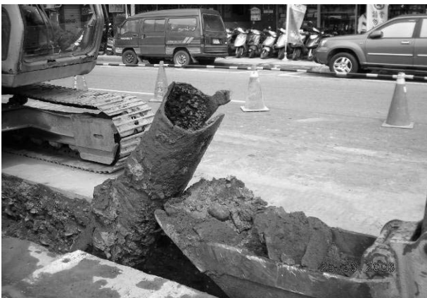
圖 21 長沙街 2 段拆除舊管照片
