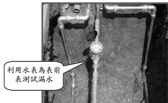
圖 1 水表表前表測試情形
