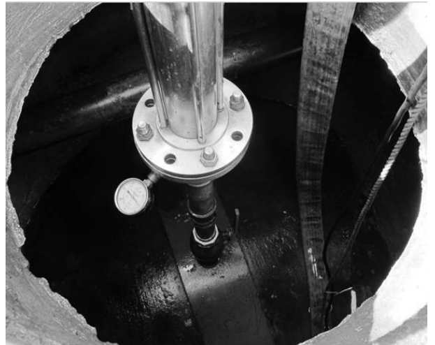
圖 6 幹管鑿開洞口插入勘測裝置
