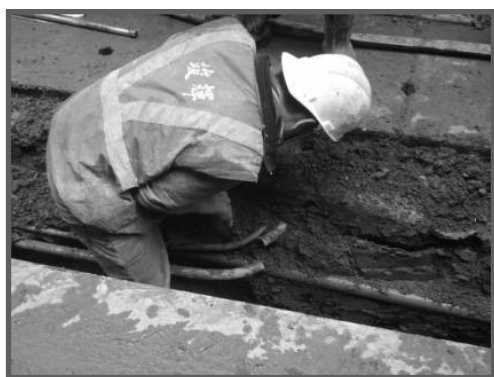
圖 9 給水管切割平整
