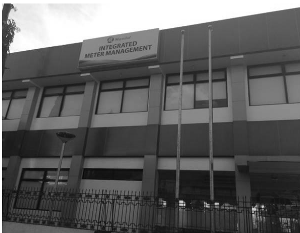
圖 10 水量計整合管理部門大樓
