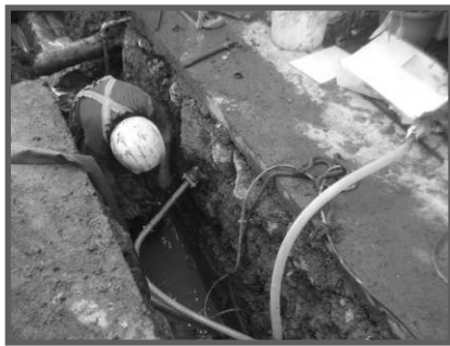
圖 13 進行管線空氣壓力測漏中
