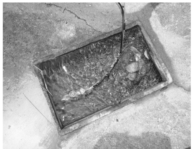
圖 2 拆卸用戶表、由直通的不鏽鋼止水栓進入外線。
