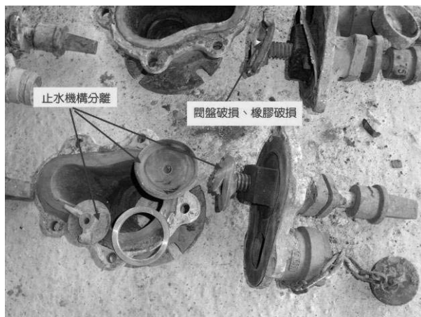
圖 7 地下式救火栓拆解後
