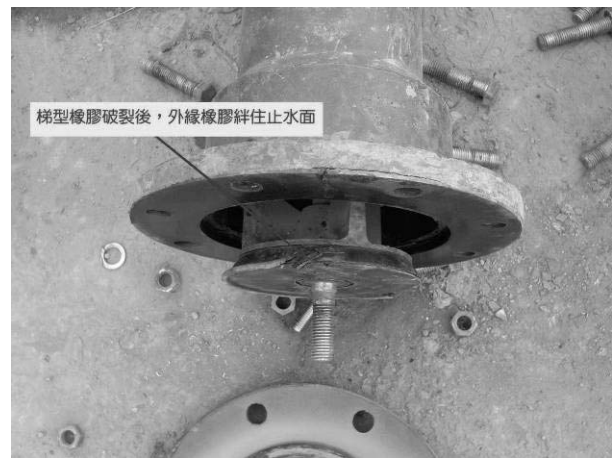
圖 6 地上式救火栓拆解後
