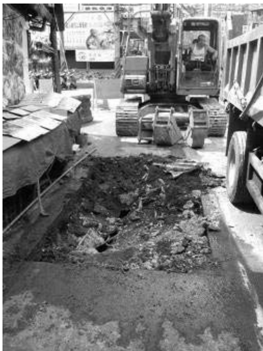
圖 8 評估表埋設位置路面開挖
