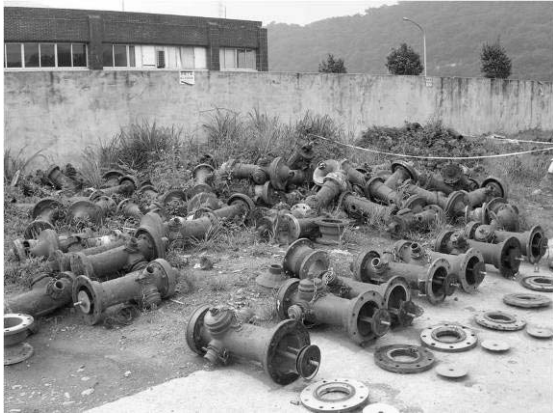
圖 3 地上式救火栓拆解 [1]
