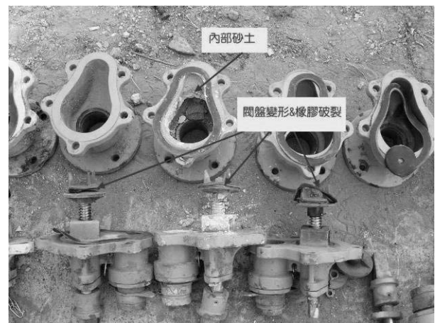
圖 8 地下式救火栓拆解後
