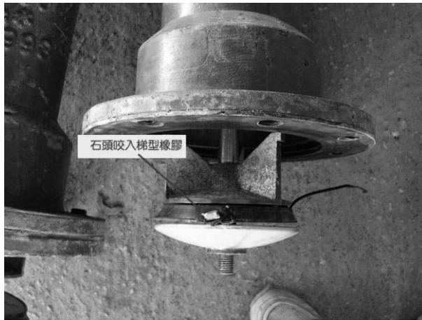
圖 5 地上式救火栓拆解後
