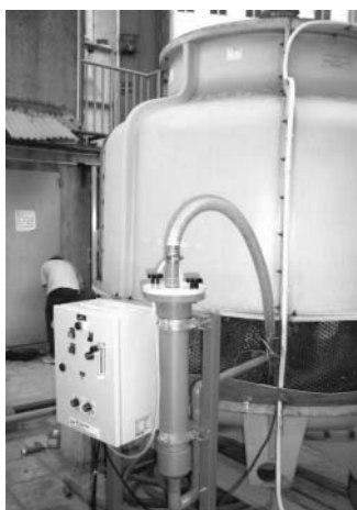
圖 2 冷卻水塔臭氧處理套裝設備
