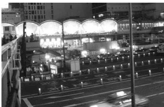
圖 8 國外施工擺放交通錐情形
