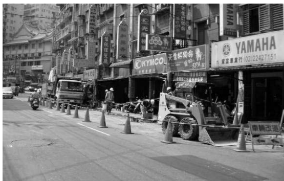
圖 6 管網改善施工
