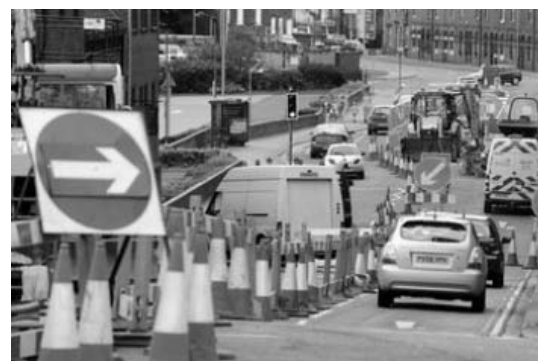
圖 9 國外施工擺放交通錐情形 [6]
