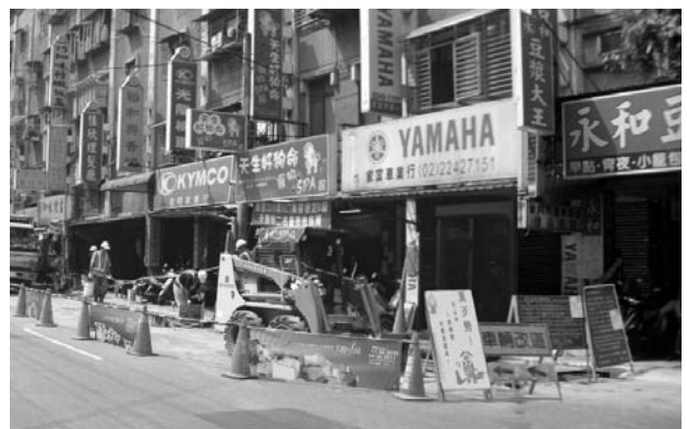
圖 19 管網改善工程現場
