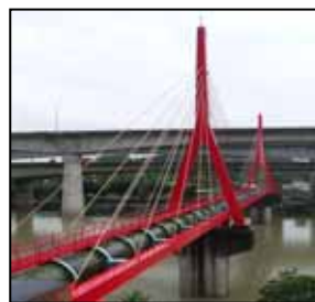
(1)鋼斜張水管橋示意圖
