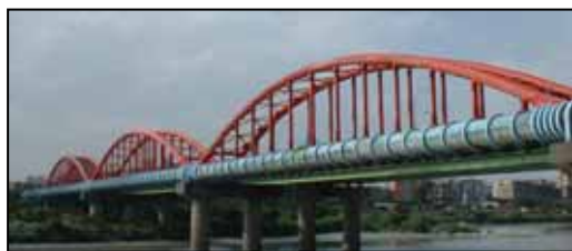
(1)鋼拱水管橋示意圖
