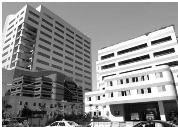
照片 2 辦公大樓及加壓站完工全景
