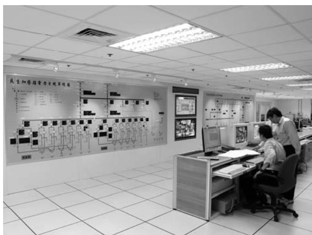
照片 3 加壓站中控室
