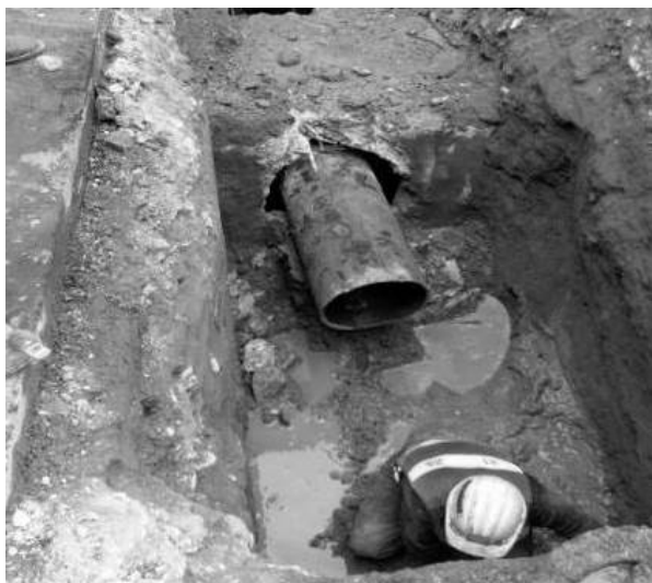
圖 9 於 106.4.1 拆除新店中正路 400mm 穿越箱涵
