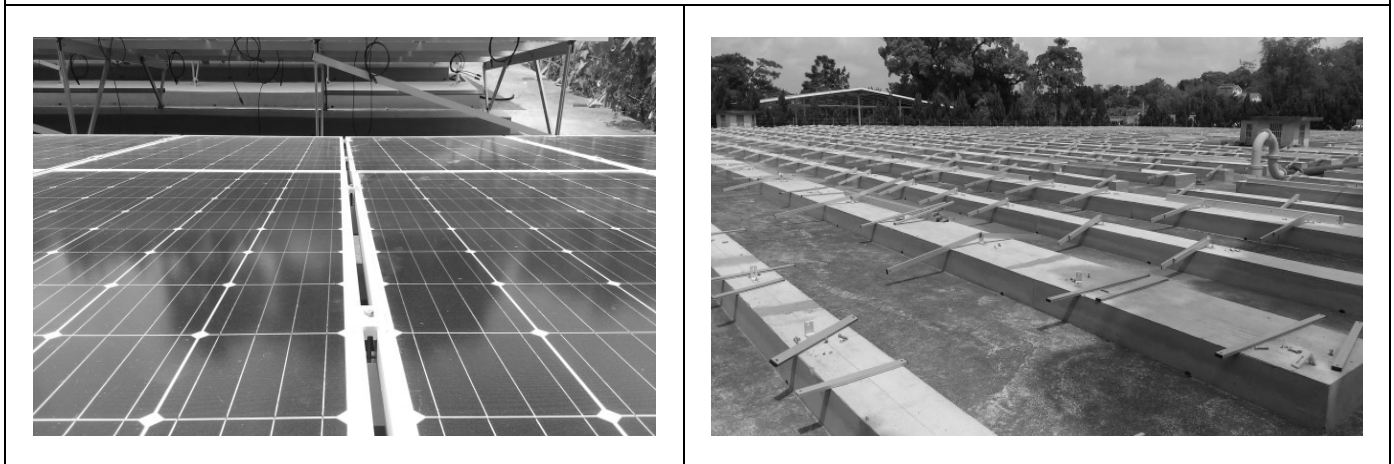
嘉義市公園淨水場-施工照片
