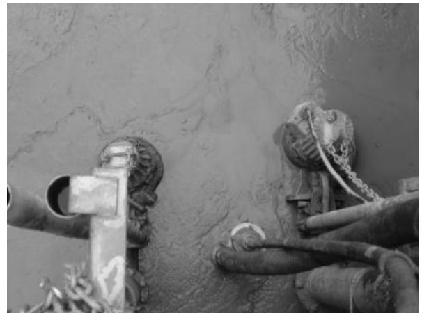
圖 5 廢水池廢水泵浸沫深度下底泥
