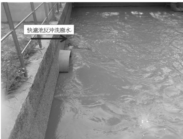
圖 7 單次排放大量反沖洗水擾動廢水池底泥
