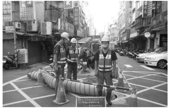
圖 2 入內勘查及施工確實做好安全措施
