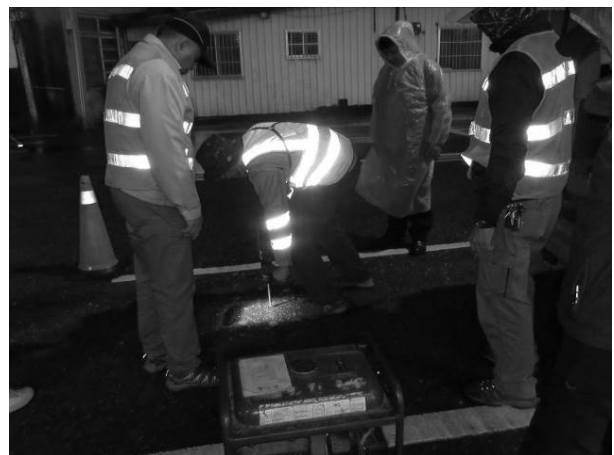
圖 6 閥盒下地，檢漏員以電錘鑽破碎再開挖
