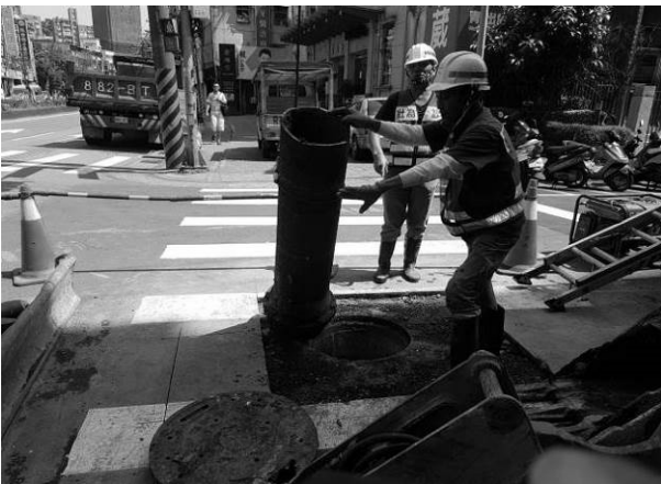
圖 18 切管後取出 350mmMJP 廢管
