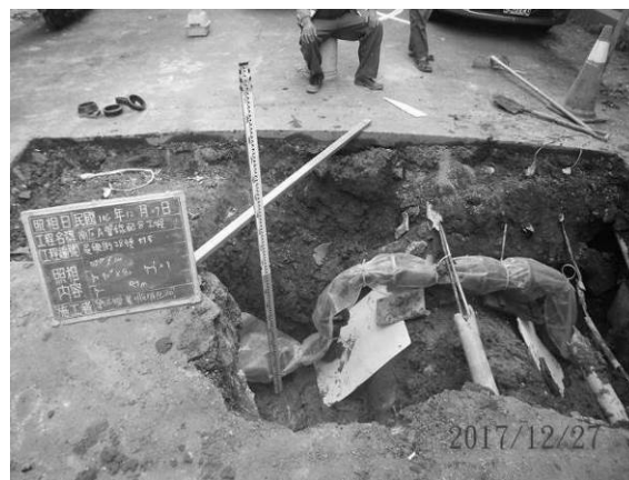
圖 25 配水管改管繞行於排水箱涵上
