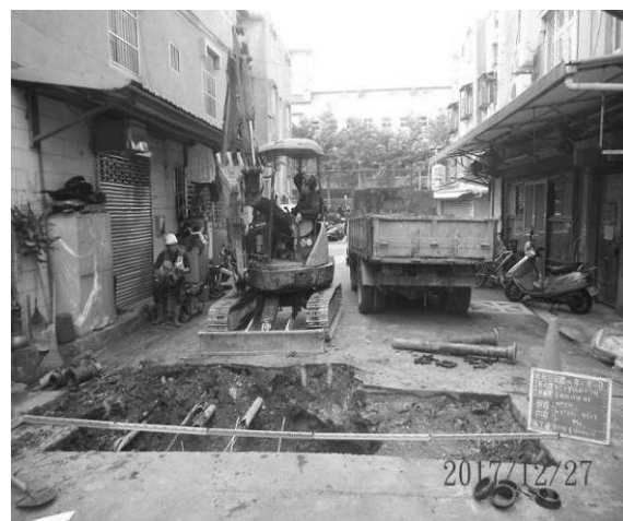
圖 24 巷內全路寬開挖以利改管
