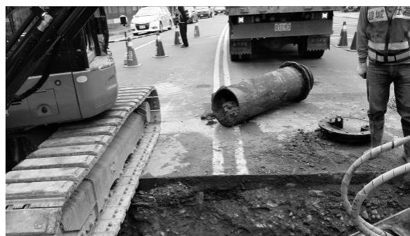
圖 10 新店區中正路分段拆除自來水管
