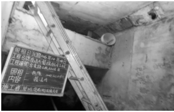
圖 12 拆除辛亥路三段 100mm 穿越箱涵段
