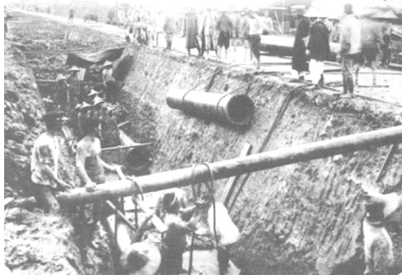
圖 4 送水幹管吊運埋設
