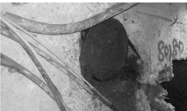
圖 19 切除後切除面與箱涵壁面齊平
