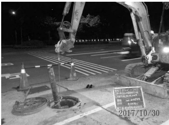
圖 13 辛亥路三段 100mm 廢管由雨水人孔取出
