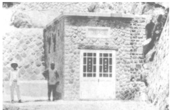
圖 5 草山第一水源取水井室
