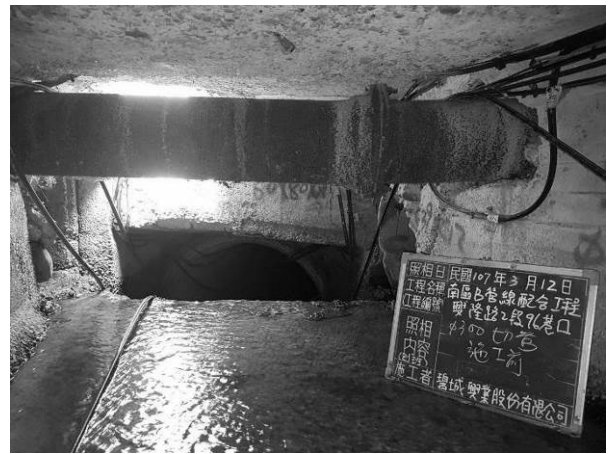
圖 14 興隆路 2 段 96 巷 2 號旁 350mmMJP 穿越二級列管案件施工前照片
