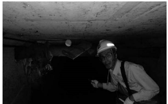
圖 4 周家榮工程師全數勘查管線橫越情形
