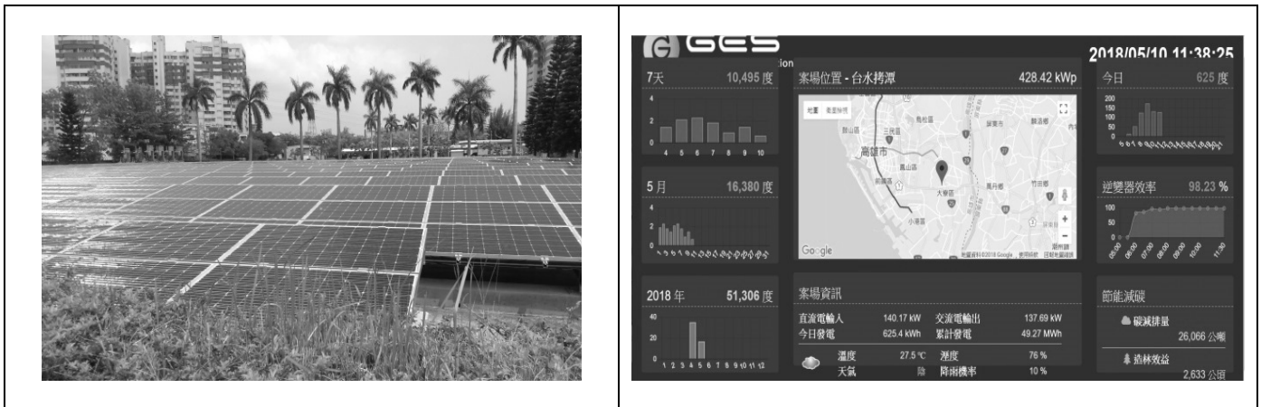
高雄市拷潭淨水場-完工後照片
