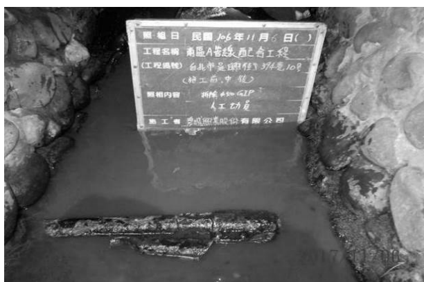
圖 22 切除下來之管線
