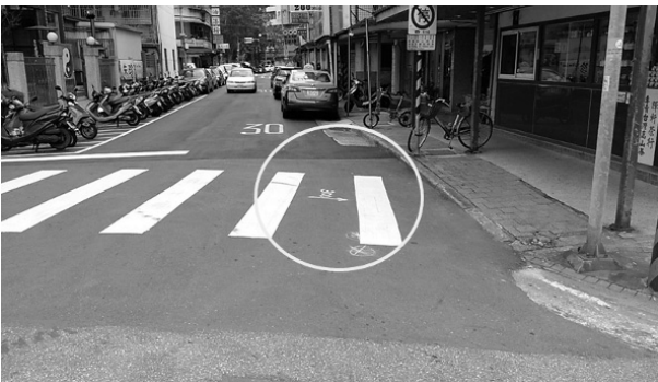
圖 17 以附近水溝隔柵板定位後確定施工位置
