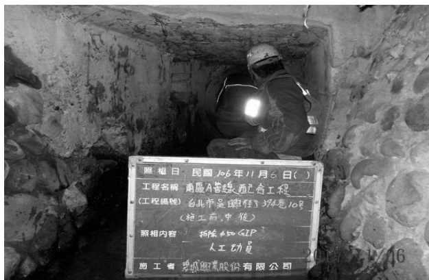
圖 21 施工人員蹲行 60 公尺後施工，備極艱辛
