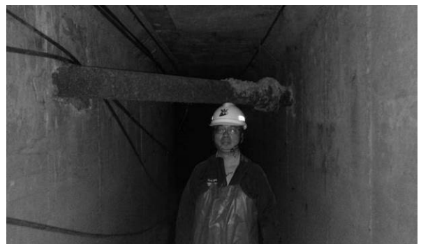
圖 5 筆者多次進入箱涵內勘查管線橫越情形
