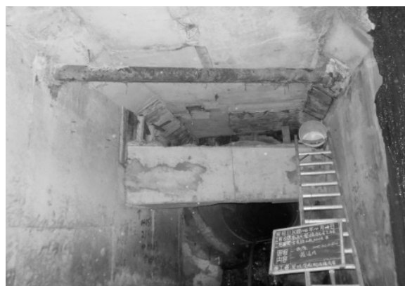
圖 11 辛亥路三段 100mm 自來水管穿越箱涵情形
