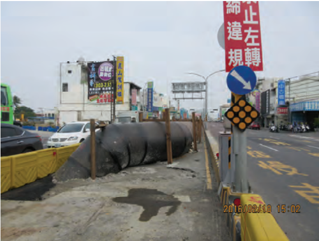
圖 6 台南崑大路緊急布設 \phi 1350 DIP 臨時輸水管供水
