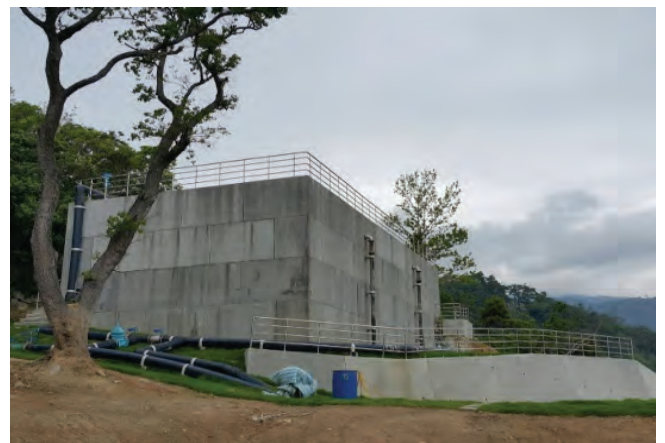
圖 3 溫泉原水儲水池
