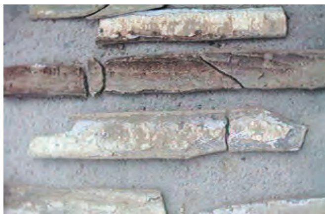
圖 5 卓蘭系統 \phi 100-DIP 管體碎裂
