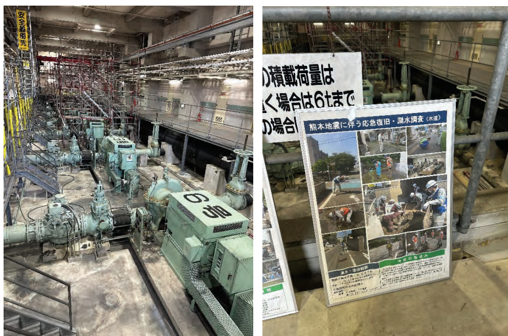
圖 11 緊急供水加壓站及地震災害搶修圖片
