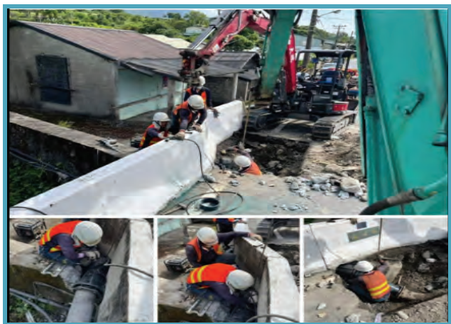
圖 6 松浦地區管線搶修
