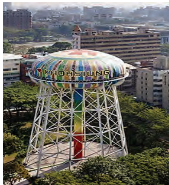
圖 1 高雄市五福路高架水塔圖
