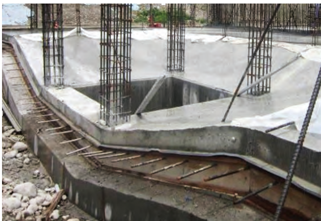
圖 5 伸縮縫止水帶及銜接鋼棒施工
