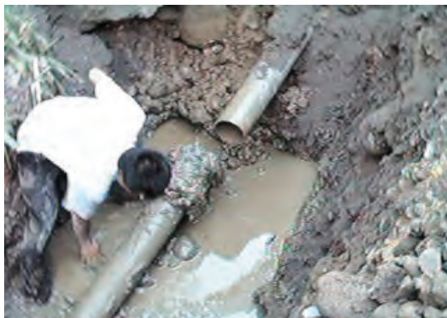
圖 2 卓蘭系統食水坑 \phi 150-PVCP 脫接約 20 公分長
