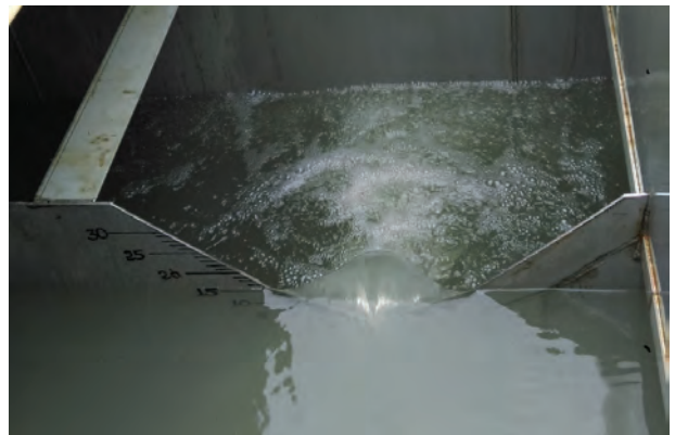
圖 7 計量設備—溫泉儲池內三角堰
