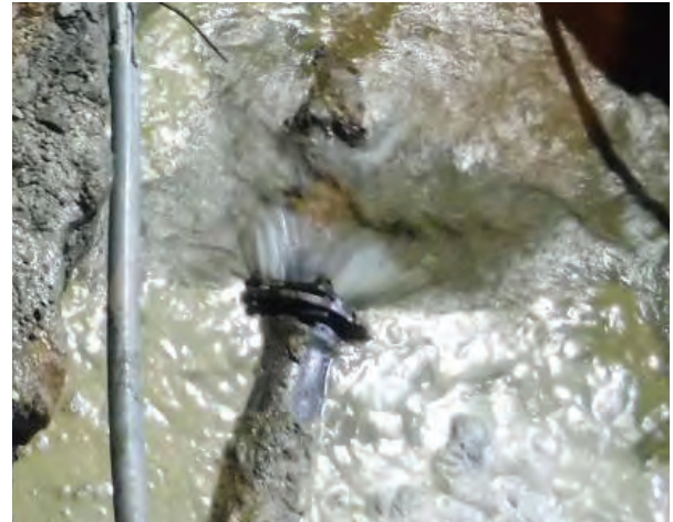
圖 9 花蓮市中正路 637-1 號 \phi 200 -DIP 接頭脫接
