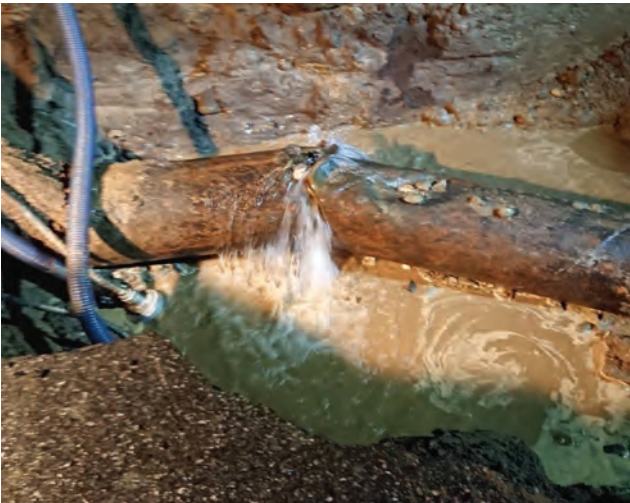
圖 7 花蓮市新興路 \phi 500 鋼管扭曲變形
