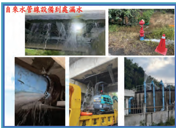
圖 3 地震造成自來水管線設備到處漏水
