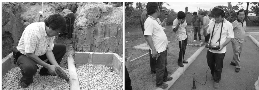
圖 6 泰國大都會自來水管理局檢漏訓練場 (Leakage Survey Training Yard)
