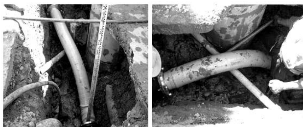
圖 13 不銹鋼波紋管施工照片(芝玉路)
