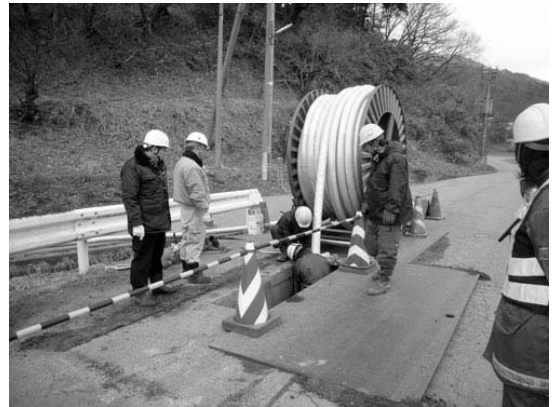
圖 5 SDF 工法現場施工情形
