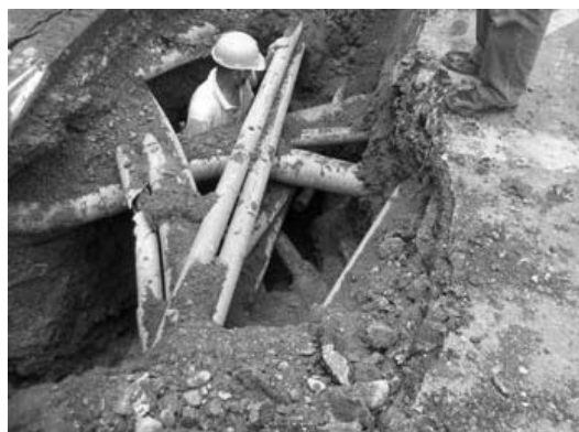
圖 2 地下管障眾多施工困難
