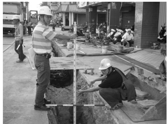
圖 3 專案工程三支距測量
