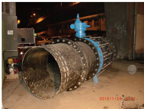
圖 12 平口另件管溝外組立完成
