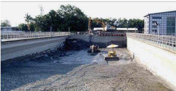
圖 6 翁公園淨水場沉砂池清理照片 1
