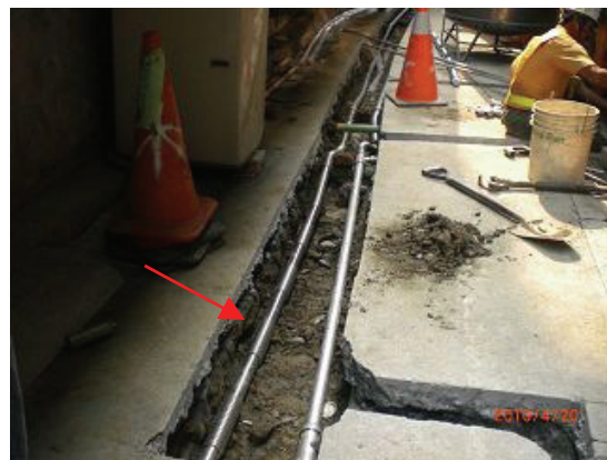
圖 11 僅需使用不銹鋼直管時，勿以波狀管替代
