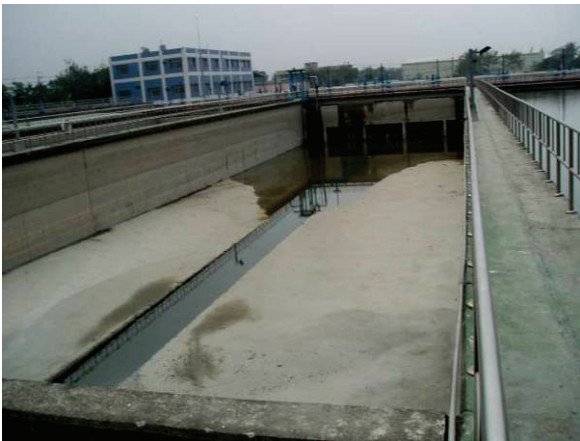
圖 3 清洗後沉砂池
