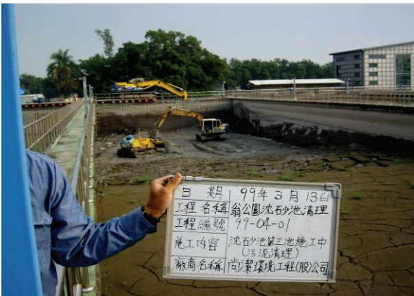
圖 7 翁公園淨水場沉砂池清理照片 2
