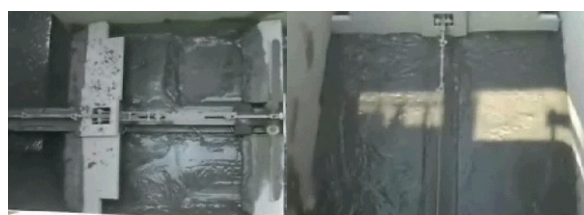
集集攔河堰初沉池單軌式刮泥機照片
