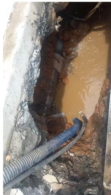
圖 14 點 2 漏水點照片
