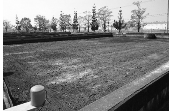
圖 6 淨水場濾池刮砂
