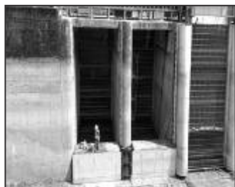
圖 3 直潭壩取水口第二道攔污柵第 8、9 門
