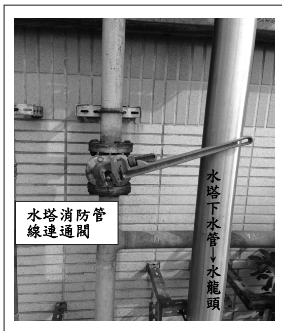
圖 3 開啟水塔消防管線連通閥
