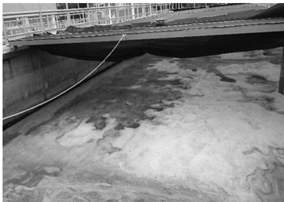
圖 13 西嶼場慢濾池輪替操作現場照片
