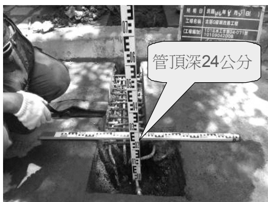
圖 10 水溝邊給水管深度情形
