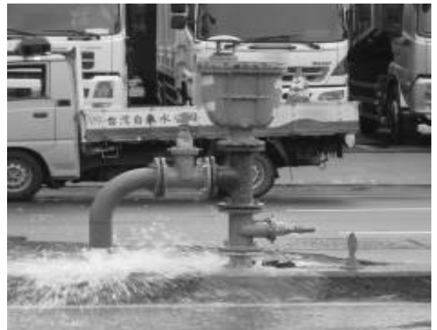
圖 11 人力進行管線排氣(水)作業
