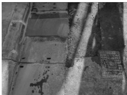
圖 13 預鑄溝蓋版復原情形
