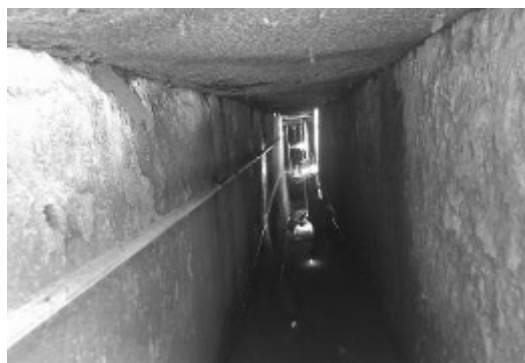
圖 12 完成後水溝內情形
