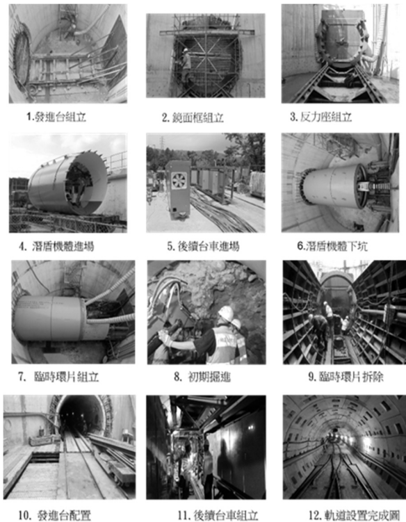
圖 9 開放式潛盾施工步驟圖
