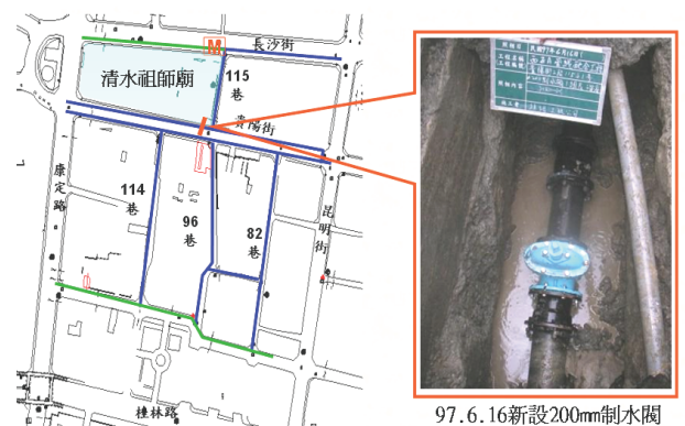
圖 12 貴陽街 115 巷口增設制水閥
