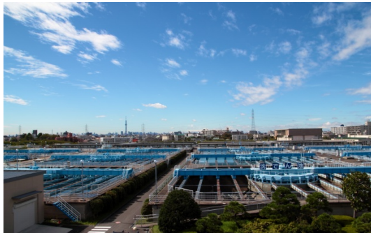
參觀金町淨水場高級處理
