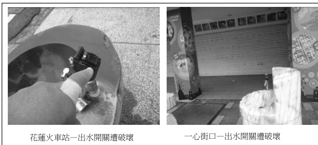
圖 5 自來水生飲台開關損壞
