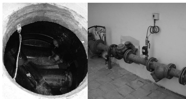
圖 8 自動讀表系統整合自來水及雨水
