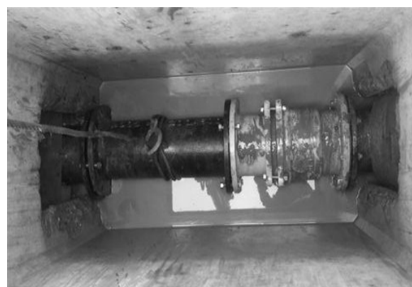
窰井內水表組換裝為雙突緣短管
