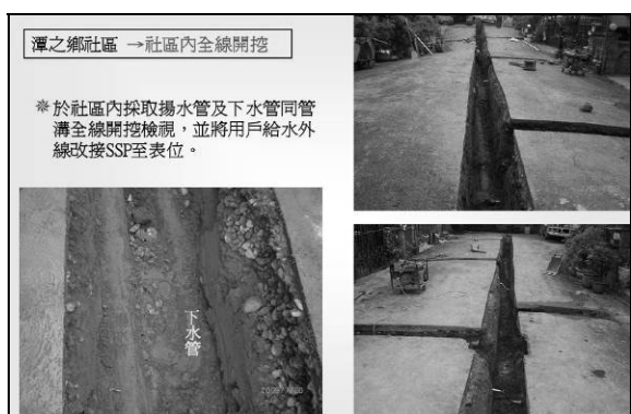
圖 4 揚水管及下水管全線開挖照片
