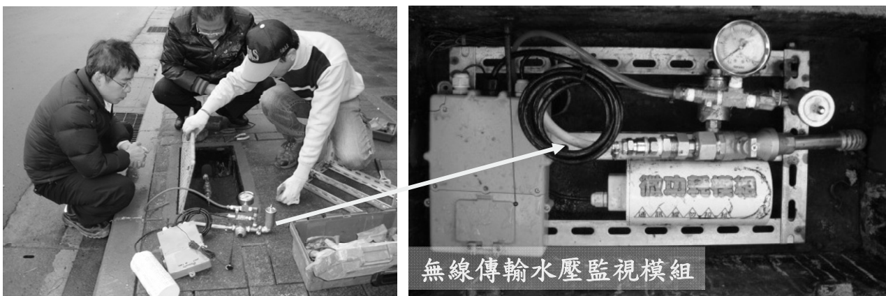
圖 9 取代傳統監視箱之無線傳輸水壓監視模組
