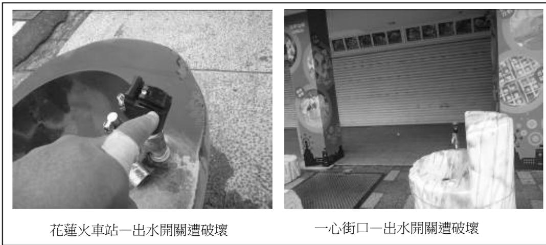
圖 5 自來水生飲台開關損壞
