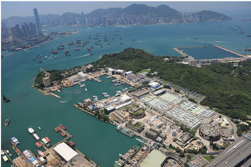
圖 25：昂船洲污水處理廠鳥瞰圖
